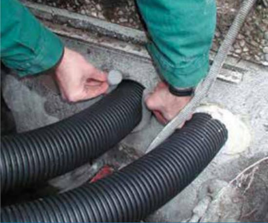
**4** Um ein Austreten des Tangit Expansionsharzes M 3000 zu vermeiden, ist es sinnvoll, eine Schalung am Ausgang des Ringspalts vorzusehen. Dazu dient die mitgelieferte Schalung oder alternativ eine flexible PUR-Schnur.
