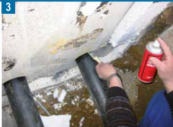
Anschließend wird der Ringspalt an der Außenseite der Wand mit einer PE-Rundschnur verschlossen und das Tangit Expansionsharz M 3000 durch die Fugestelle der PE-Rundschnur in den Ringspalt eingepresst (vgl. Bild 4).
