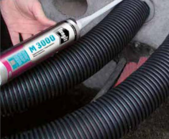
**5** Der Ringspalt zwischen Tangit Dichtschlauch M 4082 und PUR-Schnur wird mit Tangit Expansionsharz M 3000 verfüllt, um die Fixierung des Rohres im Mauerwerk zu gewährleisten. Er garantiert die vom DVGW in der VP 601 geforderten Festigkeiten. Das Tangit Expansionsharz ist nach 5 Minuten endfest und nach 30 Minuten mechanisch voll belastbar.
