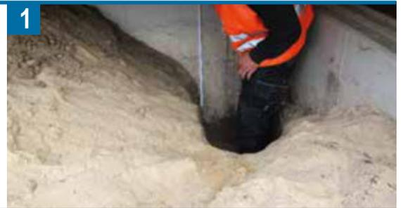
**2** Bild 2: Anschlussgrube an der Grundstücksgrenze zum Anschluss an die Versorgungsleitung. Mittels Erdrakete erfolgt die Verbindung vom Gebäude zum Anschluss
