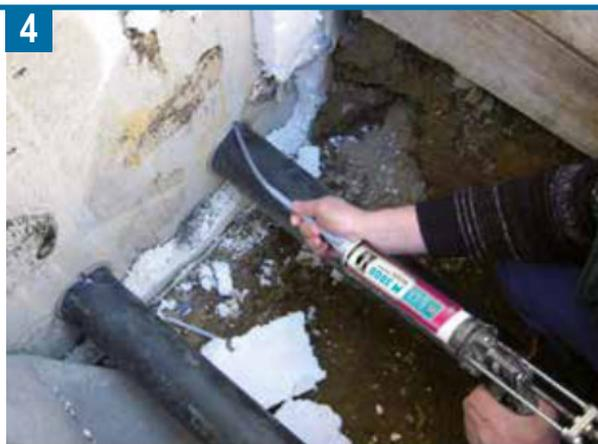
Nach abgeschlossener Expansion des Harzes (fünf Minuten) ist auch an der Fugestelle der PE-Rundschnur eine kleine Menge Harz ausgetreten. Der Ringspalt ist somit optimal gefüllt. Das ausreagierte Harz kann zusammen mit der Rundschnur entfernt werden (vgl. Bild 5). Die Montagearbeiten an der Gebäudeaußenseite sind damit abgeschlossen.
