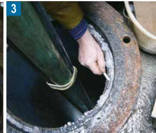
3 Ausgehärtetes Tangit M 3000 wird abgeschnitten
