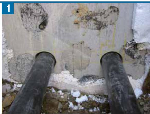
Zunächst wird der Tangit Dichtschlauch M 4082 montiert (vgl. Bild 2). Der Schlauch wird in dreifacher Wicklung bis ca. in die Wandmitte in den Ringspalt eingeschoben.
