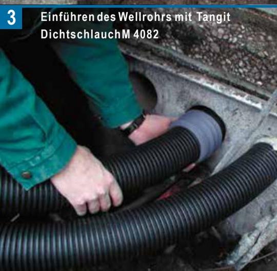
**4** Einführen des Wellrohrs mit Tangit Dichtschlauch M 4082
