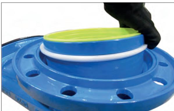
5. Sicherungsring montieren
