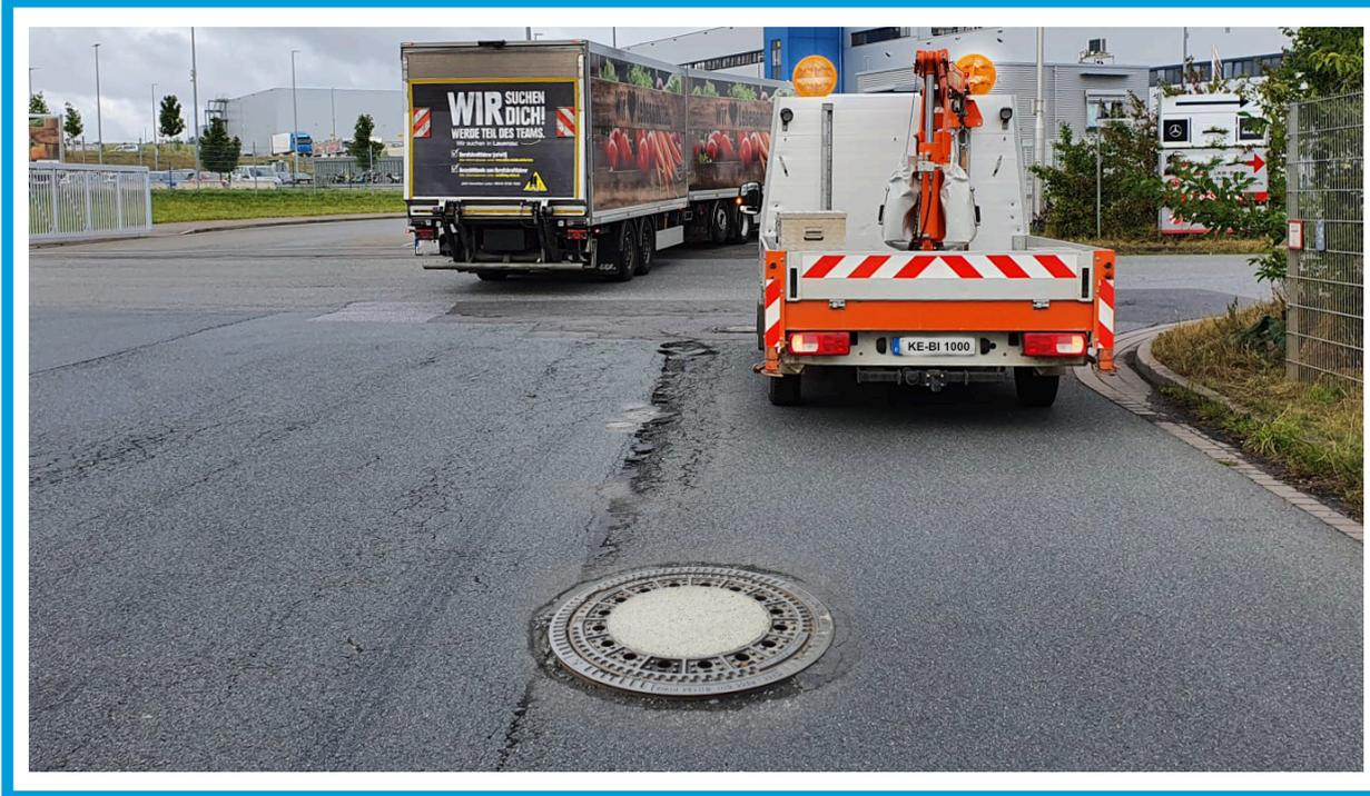
Zunehmender Schwerlastverkehr braucht bedarfsgerechte Lösungen. Die BUDAPLAN®- Schachtabdeckung mit konischem Rahmen bietet die Lösung. Durch die Pfropfwirkung kann die Schachtabdeckung nicht mehr absinken und Unebenheiten in der Fahrbahndecke werden vermieden.
