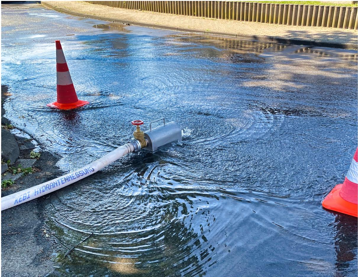
**KEBI Druckvernichter zur sicheren Vernichtung
