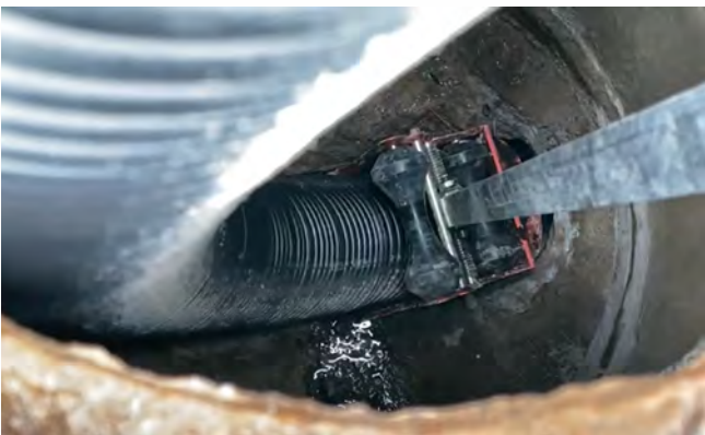
5c) Einführen des FLEXIROHRes in die unterirdische Einzugshilfe
