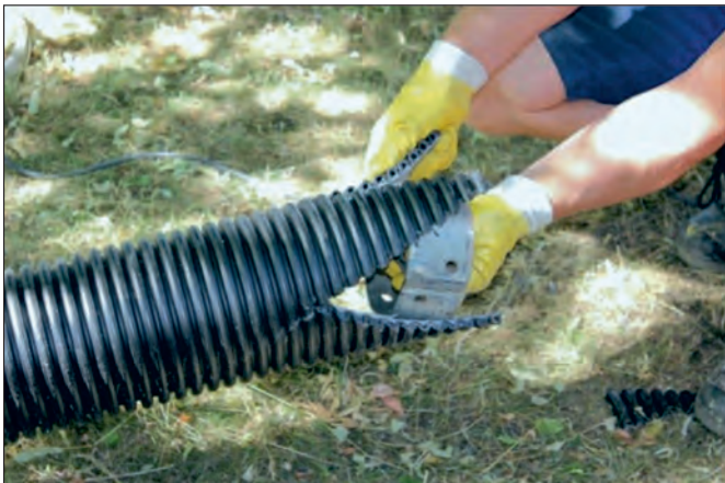
3b) Einsetzen des Zugkopfes
