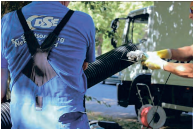
3a) V-förmiger Einschnitt am Rohrende, auf 3:00 / 6:00 / 9:00 und 12:00 Uhr mit einer Länge von mind. 5-6 Rippen
