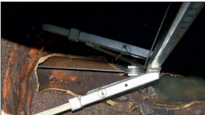
4c) Stahlseilumlenkung im Zielschacht
