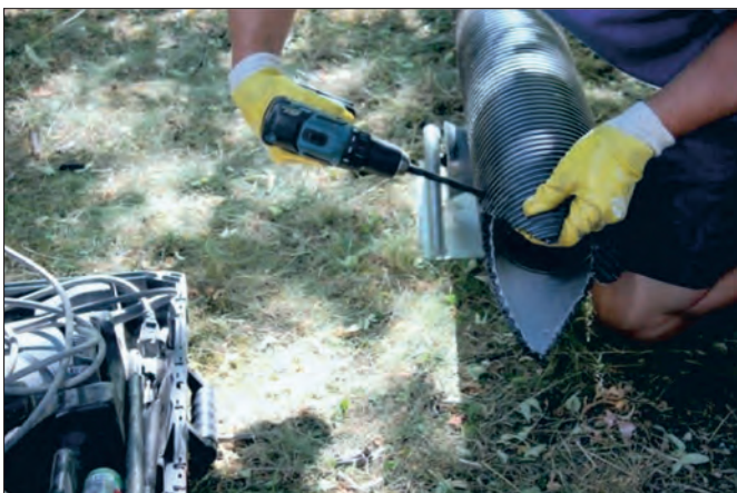
3c) Befestigung des Zugkopfes mittels mind. 4 Schlossschrauben
