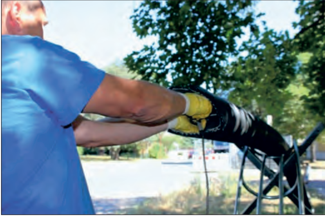
3d) Zugseil an Zugkopf anschließen
