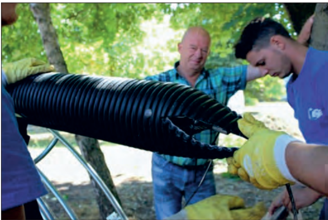
3e) Zentrisches Zusammenbinden des Rohrendes
