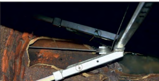
5d) Seilwinde mit Stahlseilumlenkung für das kontinuierliche Ziehen des FLEXIROHRes zum Zielschacht
