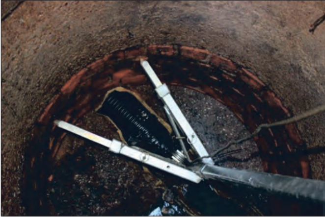
5e ) FLEXIROHR im Zielschacht
