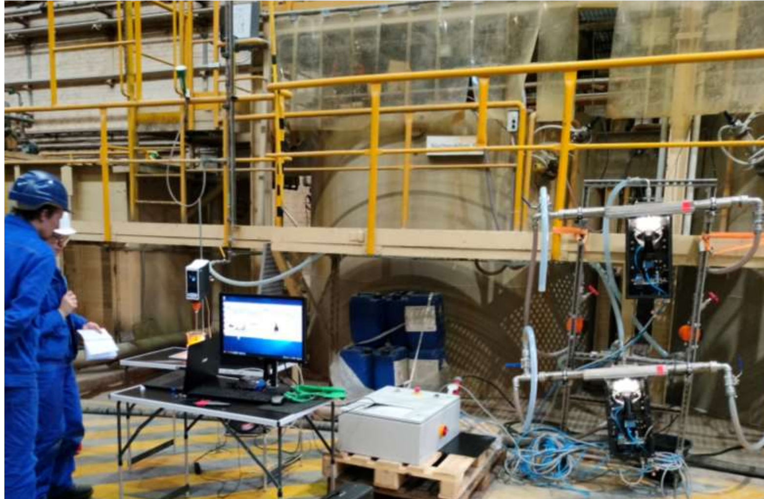
Mobiler Aufbau im Bypass
